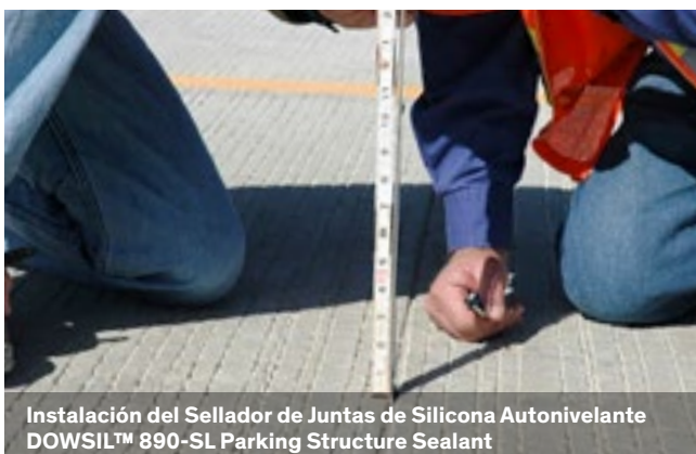
Instalación del Cordón de Respaldo
