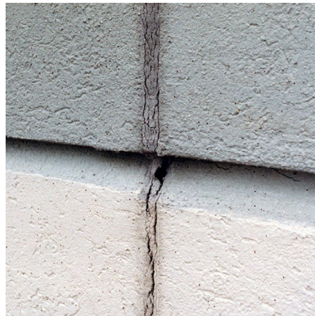
Verwerfungen bei Polyurethandichtstoffen und Umkehr der Aushärtungsreaktion bei Polyurethandichtstoffen
