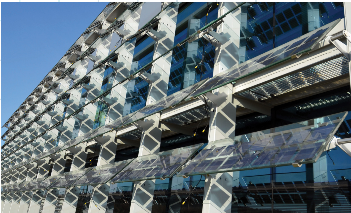
Fotowoltaika zintegrowana z elewacjami inteligentnych budynków przyczynia się do obniżenia emisji operacyjnego dwutlenku węgla.
