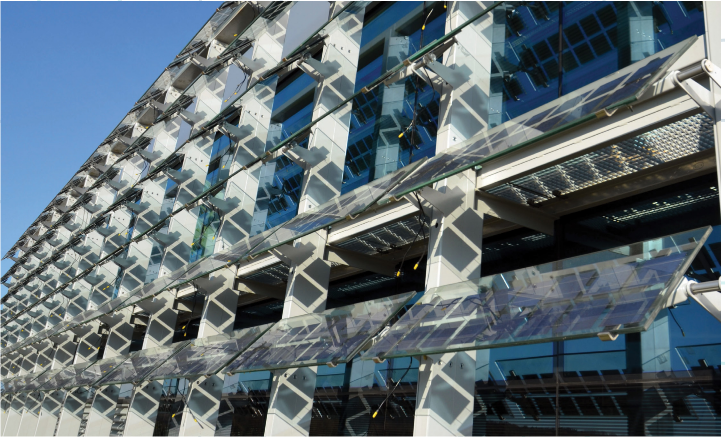
Integrierte Photovoltaik in intelligenten Gebäudefassaden trägt zu einer Verringerung der betriebsbedingten CO 2 -Emissionen bei.
