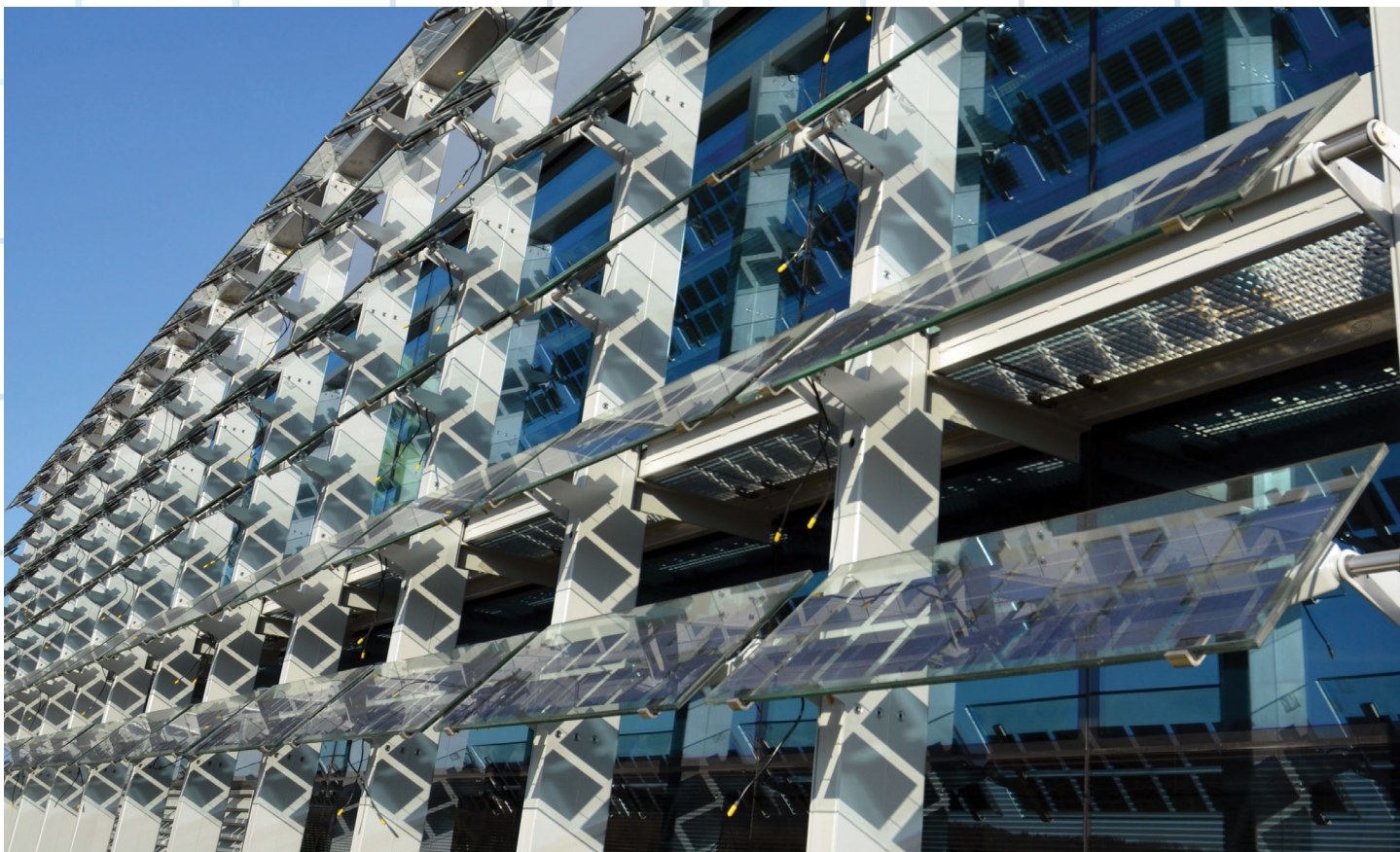
Les panneaux photovoltaïques intégrés aux façades des bâtiments intelligents contribuent à réduire les émissions de carbone opérationnelles.
