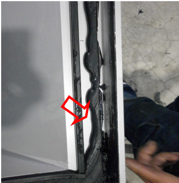
檢查發現結構密封膠填充不完整（右圖顯示為接縫填充良好）。
