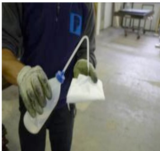
清洗基材時應使用抗溶劑侵蝕的容器。
