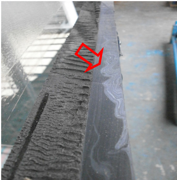
檢查發現結構密封膠混合不均勻，有花膠現象。
