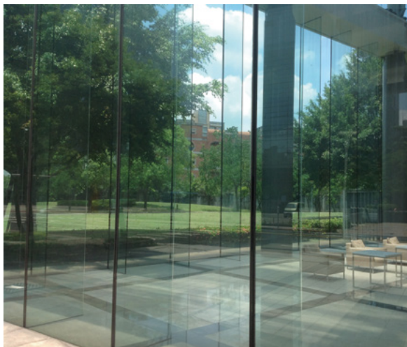
圖21: 典型的建築物大廳全視野系統
