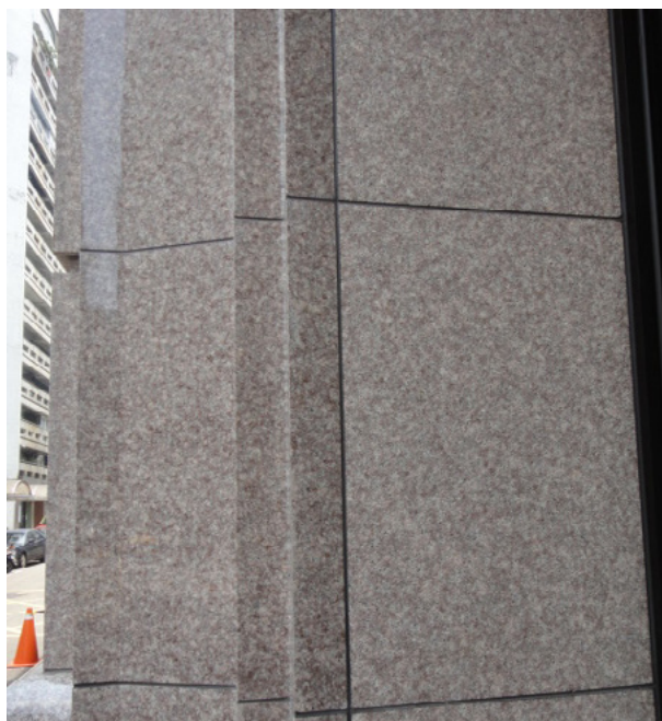
圖4：用於石材外牆專案的陶熙™ (DOWSIL™) 991高性能矽酮密封膠在暴露24個月後顯示沒有使白色和紅色花崗岩污染。另一個專案應用是臺北市的微晶玻璃外牆；在暴露24個月後，該密封膠可以使建築物表面保持更加清潔並明顯地沾染更少的灰塵（右圖）。
