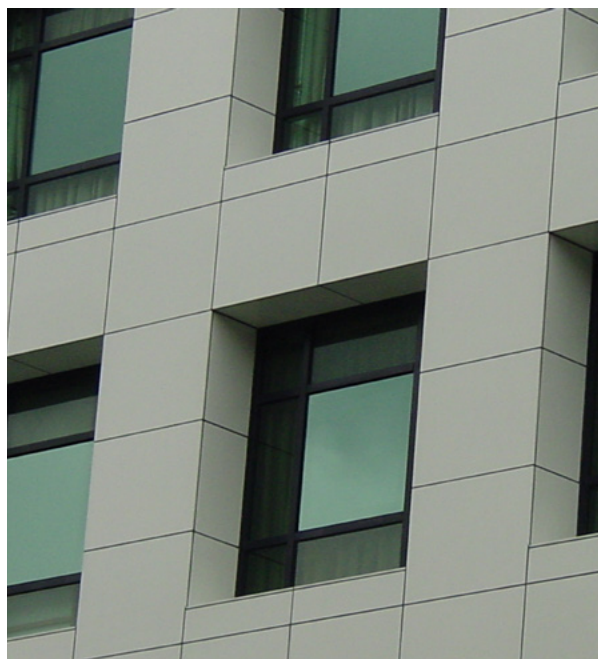
圖4：用於石材外牆專案的陶熙™ (DOWSIL™) 991高性能矽酮密封膠在暴露24個月後顯示沒有使白色和紅色花崗岩污染。另一個專案應用是臺北市的微晶玻璃外牆；在暴露24個月後，該密封膠可以使建築物表面保持更加清潔並明顯地沾染更少的灰塵（右圖）。
