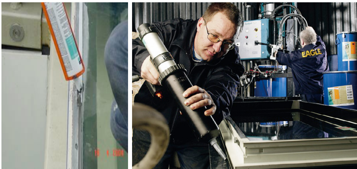
圖3：密封膠（即陶熙™（DOWSIL™）995）可用於工廠應用和施工現場應用
