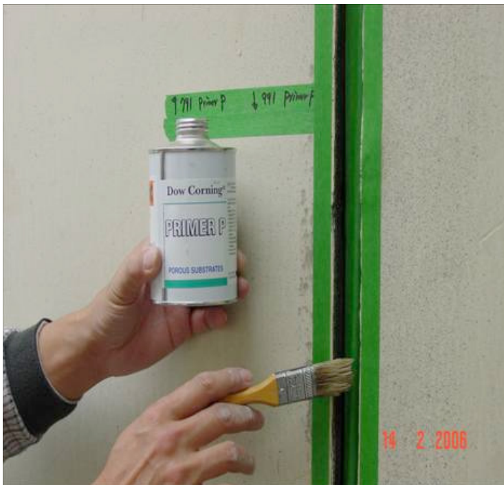
圖6：陶熙™ (DOWSIL™) P建築用密封膠底漆是一種成膜底漆，可用刷子塗敷到混凝土基材上。
