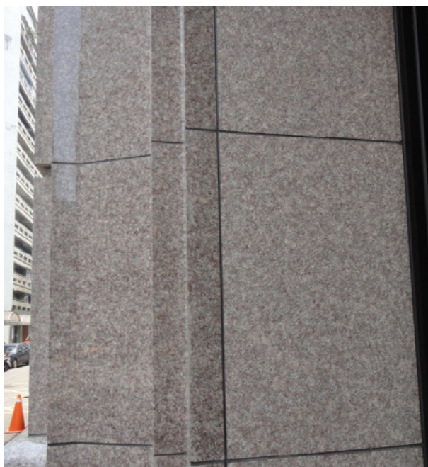
图4: 用于石材外墙项目的DOWSIL™ 991高性能硅酮密封胶在暴露24个月显示没有使白色和红色花岗岩污染。另一个项目应用是台北市的微晶玻璃外墙; 在暴露24个月后, 该密封胶可以使建筑物表面保持更加清洁并明显地沾染更少的灰尘 (右图)。
