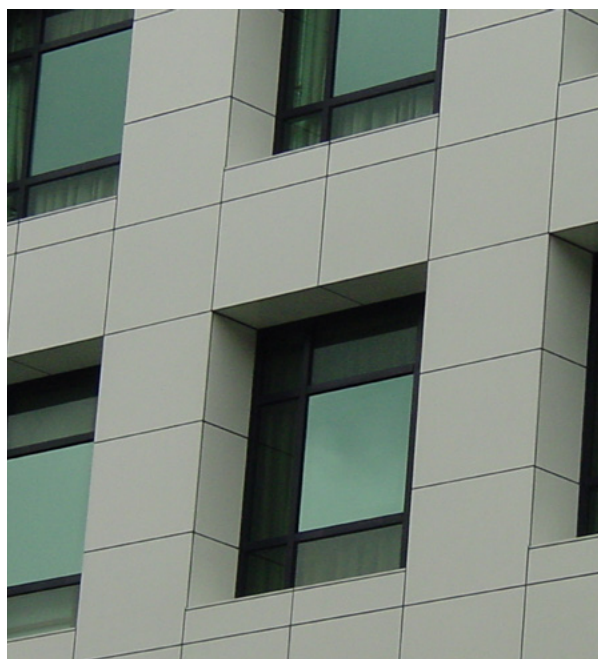
图4: 用于石材外墙项目的DOWSIL™ 991高性能硅酮密封胶在暴露24个月显示没有使白色和红色花岗岩污染。另一个项目应用是台北市的微晶玻璃外墙; 在暴露24个月后, 该密封胶可以使建筑物表面保持更加清洁并明显地沾染更少的灰尘 (右图)。
