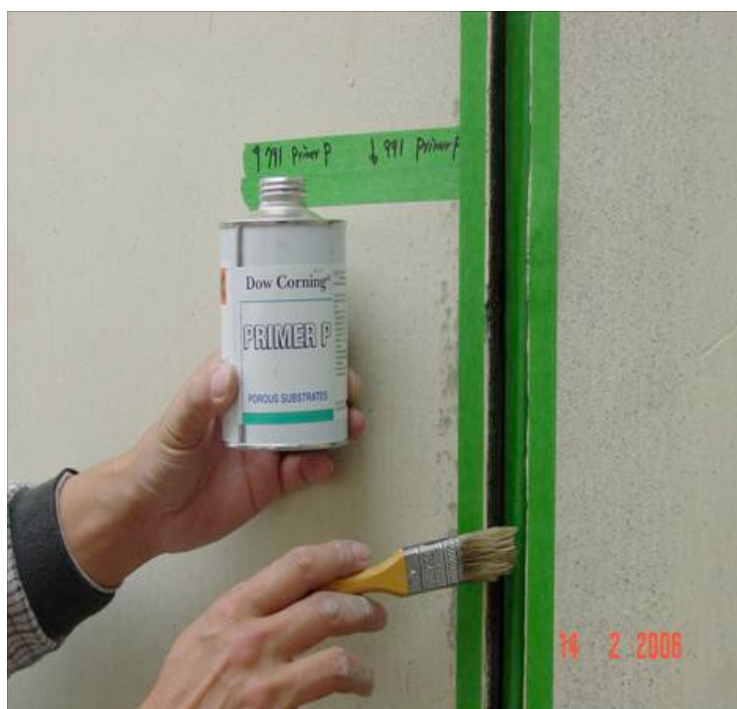
图6：DOWSIL™ P建筑用密封胶底涂液是一种成膜底漆，可用刷子涂敷到混凝土基材上。
