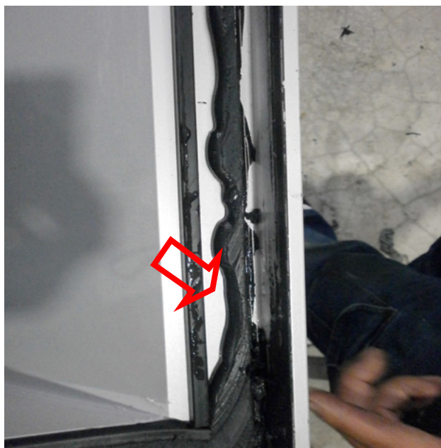
检查发现结构密封胶填充不完整（右图显示为接缝填充良好）。
