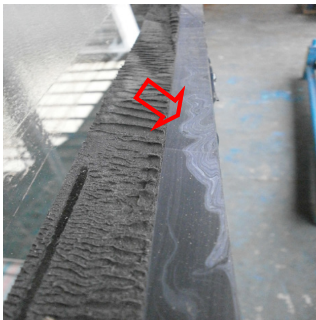
检查发现结构密封胶混合不均匀，有花胶现象。
