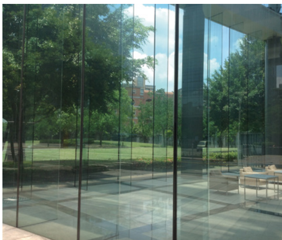
图21: 典型的建筑物大厅全视野系统
