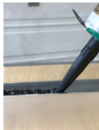
Rys. 16: Nakładanie szczeliwa silikonowego do uszczelnienia pogodowego
