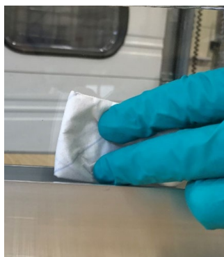
Rys. 15: Czyszczenie tafli szkła przed nałożeniem uszczelnienia pogodowego
