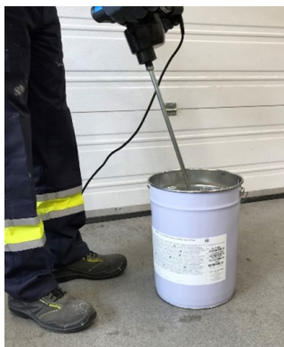
Rys. 10: Mieszanie zawartości wiadra ze składnikiem A
