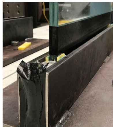
Rys. 7: Zabezpieczyć końce profilu U i wyregulować położenie za pomocą klinów dystansowych.
