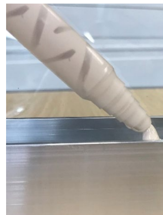
Figura 11: Inyecte la mezcla de las partes A y B en el perfil en U
