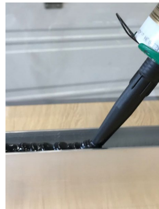
Figura 16: Aplique el sellador de silicona para la estanqueidad
