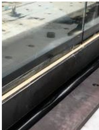
Figura 14: DOWSIL™ 375 Construction & Glass Embedding en perfil en U
