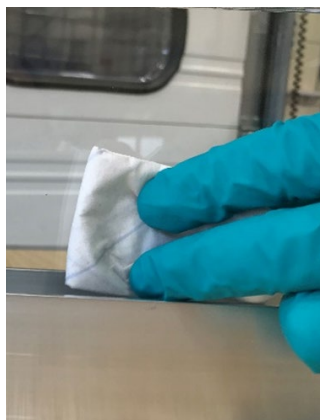
Figura 15: Limpie el vidrio antes de aplicar el sellado de estanqueidad
