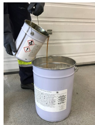
Figura 12: Vierta el endurecedor de la parte B en el cubo de la parte A
