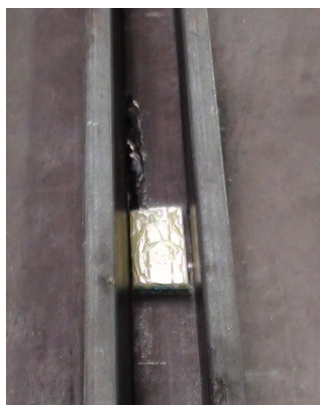
Figura 5: Coloque bloques de fijación en la base del perfil en U
