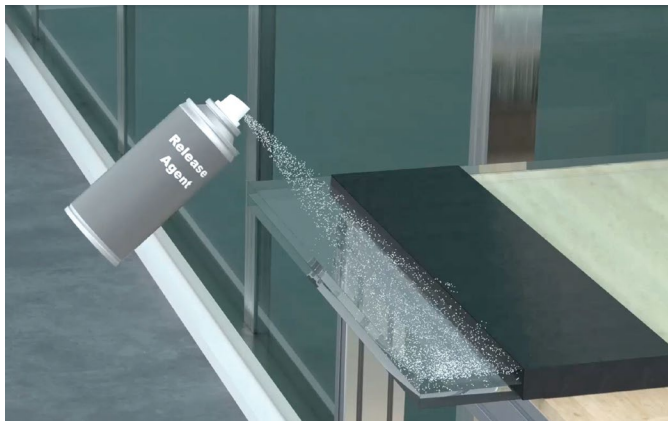
Figura 3: Aplique agente desmoldante en spray en el vidrio
