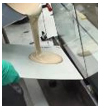
Figura 13: Utilice una placa para llenar el perfil en U con el material de incrustación de paneles de vidrio
