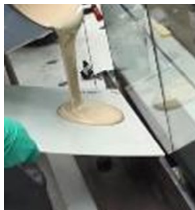
Figura 13: Usando una piastra guida, riempire il profilo a U del materiale di incasso
