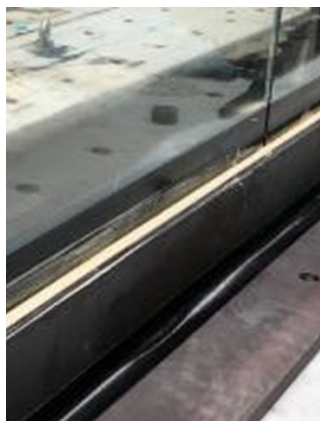
Figura 14: DOWSIL™ 375 Construction & Glass Embedding nel profilo a U
