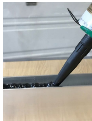
Figura 16: Applicare il sigillante al silicone per ottenere la protezione dagli agenti atmosferici
