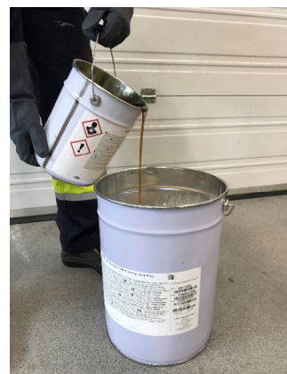
Figura 12: Versare l'indurente della parte B nel secchio della parte A
