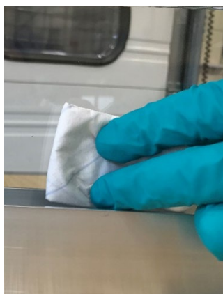
Figura 15: Pulire il vetro prima di applicare il sigillante resistente agli agenti atmosferici
