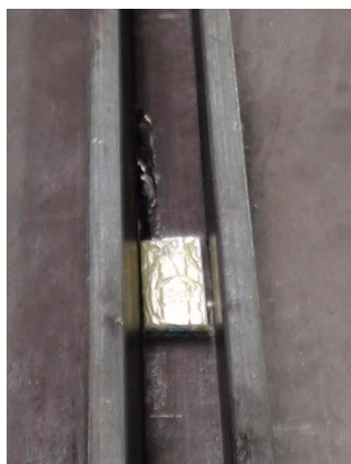
Figura 5: Posizionare i blocchi di fissaggio sul fondo del profilo a U
