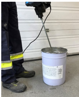
Figura 10: Miscelare il contenuto del secchio della parte A
