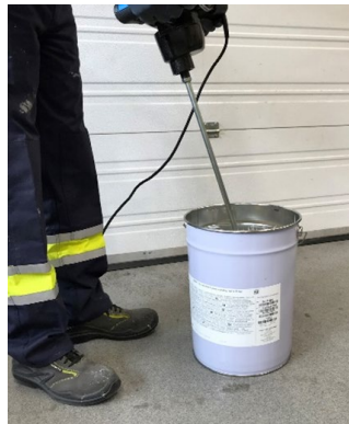
Abbildung 10: Komponente A aufrühren
