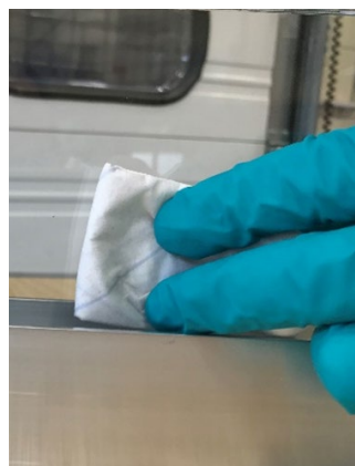
Abbildung 15: Glas vor Auftragen der Wetterversiegelung säubern
