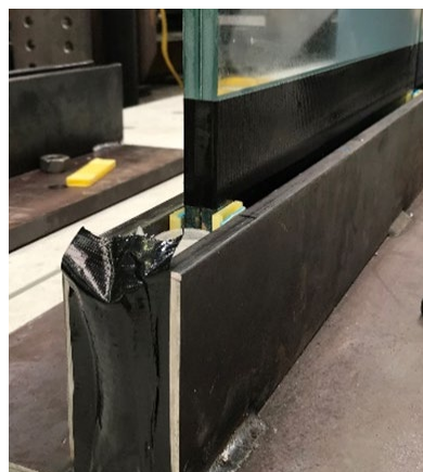
Abbildung 7: Enden des U-Profils verschließen und Tragklötze ausrichten
