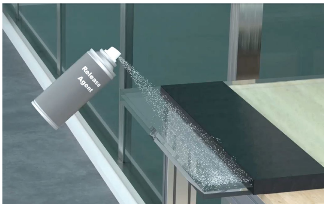
Abbildung 3: Trennmittel auf Glasscheibe sprühen
