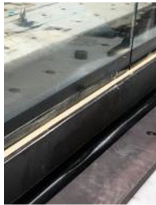
Abbildung 14: DOWSIL™ 375 Construction & Glass Embedding in U-Profil
