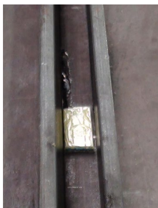
Abbildung 5: Tragklötze in das U-Profil einlegen
