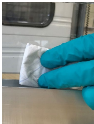
Figure 15: Nettoyage du verre avant l'application du mastic d'étanchéité
