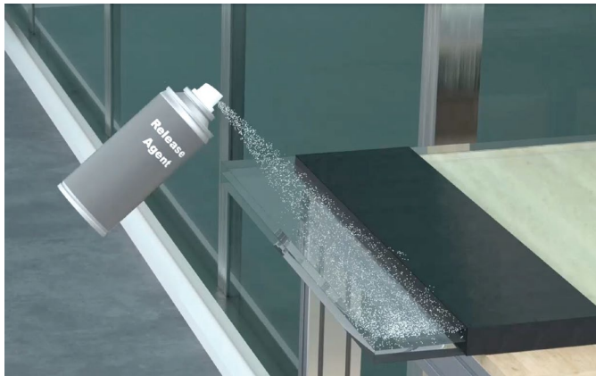
Figure 3: Pulvérisez l'agent de démoulage sur le verre
