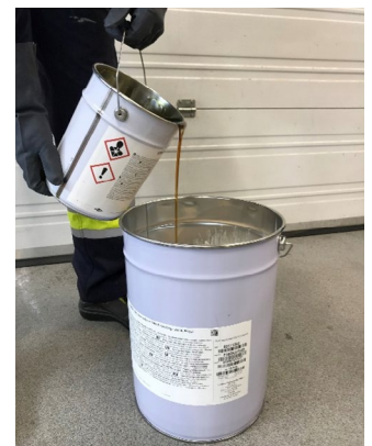
Figure 12: Versez le composant B (durcisseur) dans le seau du composant A
