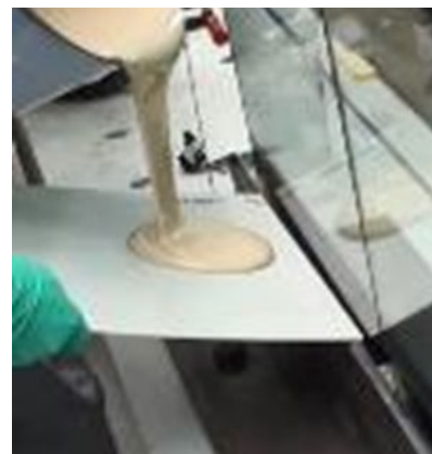
Figure 13: Utilisation d'une plaque de guidage pour remplir le profilé en U de produit de scellement
