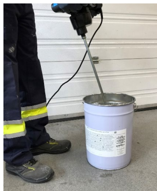
Figure 10: Mélange du composant A dans le seau
