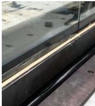
Figure 14: DOWSIL™ 375 Construction & Glass Embedding dans un profilé en U
