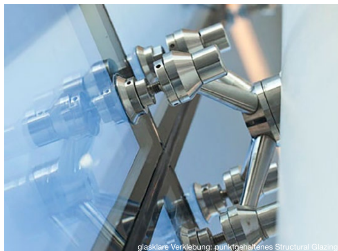
glasklare Verklebung: punkthaltiges Structural Glazing
