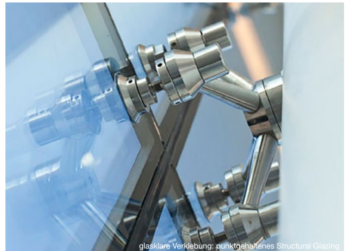
glasklare Verklebung: punktgehaltene Structural Glazing
