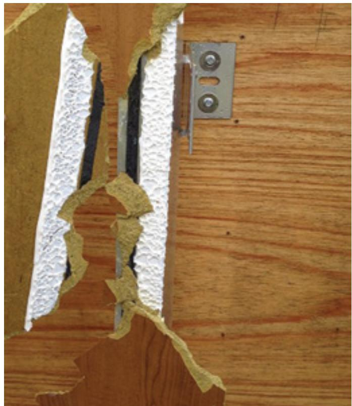
6. Positionieren Sie die Platte durch leichtes Pressen und korrigieren Sie die Position, falls nötig. Der Installateur sollte Plattensauber, Klötze, Abstandshalter oder andere geeignete Hilfsmittel verwenden, um die Platte ordnungsgemäß zu positionieren. Stellen Sie sicher, dass das DOWSIL™ PanelFix Tape-Klebeband einen vollflächigen Kontakt mit den Innenflächen der Platte und der Tragkonstruktion hat.
