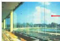
Acristalamiento con silicona estructural de cuatro lados
