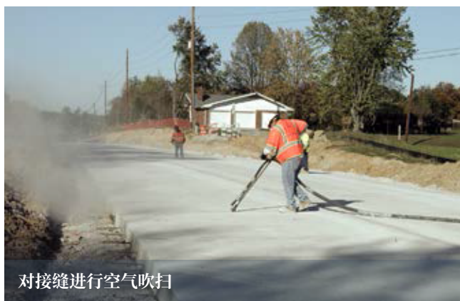
喷砂处理接缝
